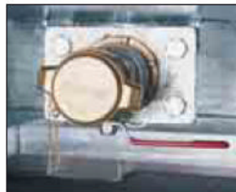
Detailabbildungen: Absperrarmatur mit 2"-Kugelhahn
